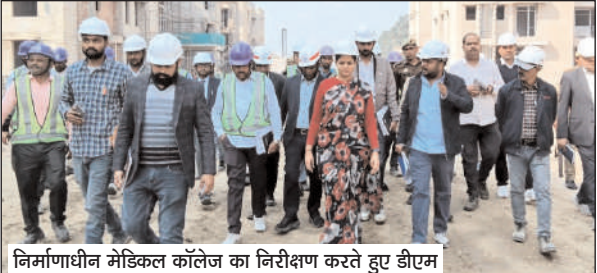
निर्माणाधीन मेडिकल कॉलेज का निरीक्षण करते हुए डीएम
